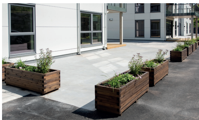
Plantekasser i bakkant av bygg B.
