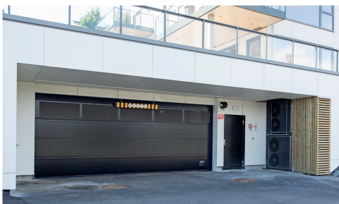
Garasjeport, dør og vifter som trekker luft ut fra parkeringsanlegget.
