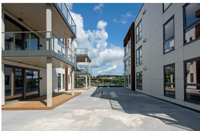
Åpning mellom bygg B og bygg C.
